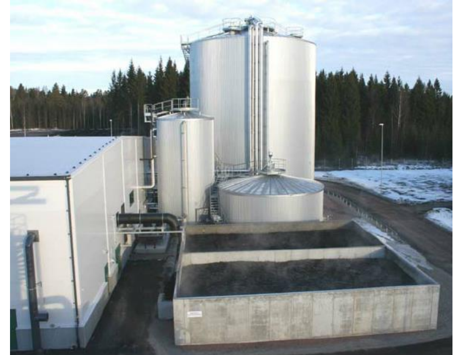
Vaxtkraft biogas production plant (waste-to-gas)
